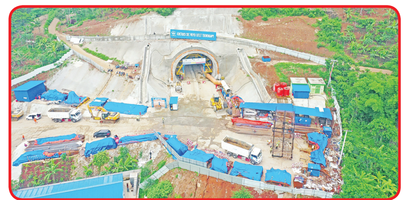
Pintu keluar Terowongan No.11 yang sudah tersambung.
